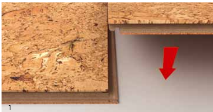
Lamela se čelní stranou těsně přiloží k již položenému prknu.
