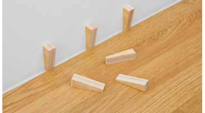
Dřevěné klíny pro správný odstup od stěny.
