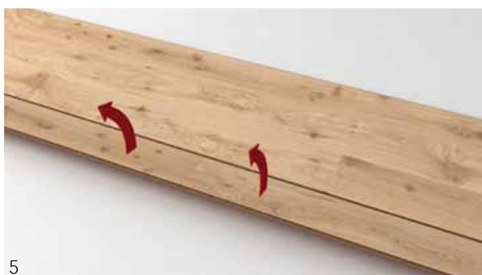
5 Při demontáži se zablokováná řada nadzvedne a vypáčí.
